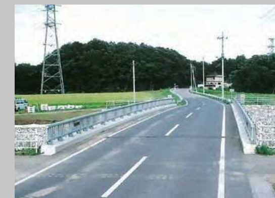
落合橋(那須町・漆塚地内)
