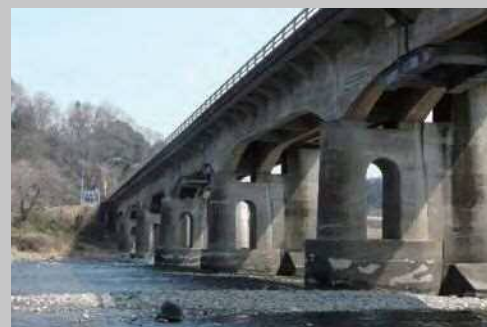
新那珂橋(撤去前状況)
