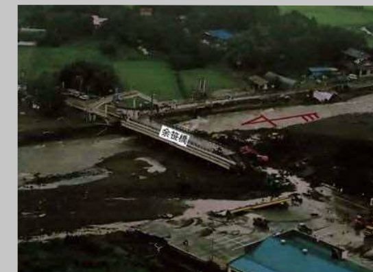
国道4号余笹橋 被災時の状況
