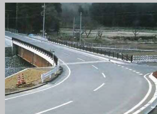
黒川橋(那須町・黒川地内)
