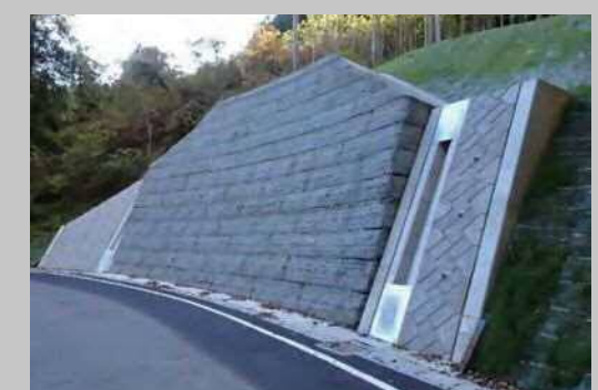
鹿沼日光線 擁壁 復旧状況(ジオテキスタイル)
