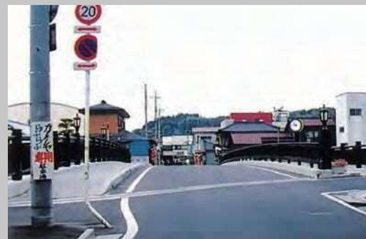
復旧後の御本陣橋(L=40.9m W=8.0m)
