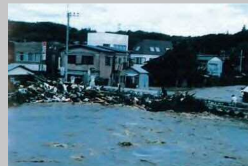
御本陣橋の被災状況
